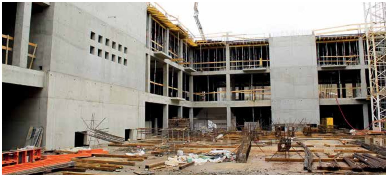
Dokončení výstavby Centra duševní rehabilitace se odhaduje na rok 2024.
